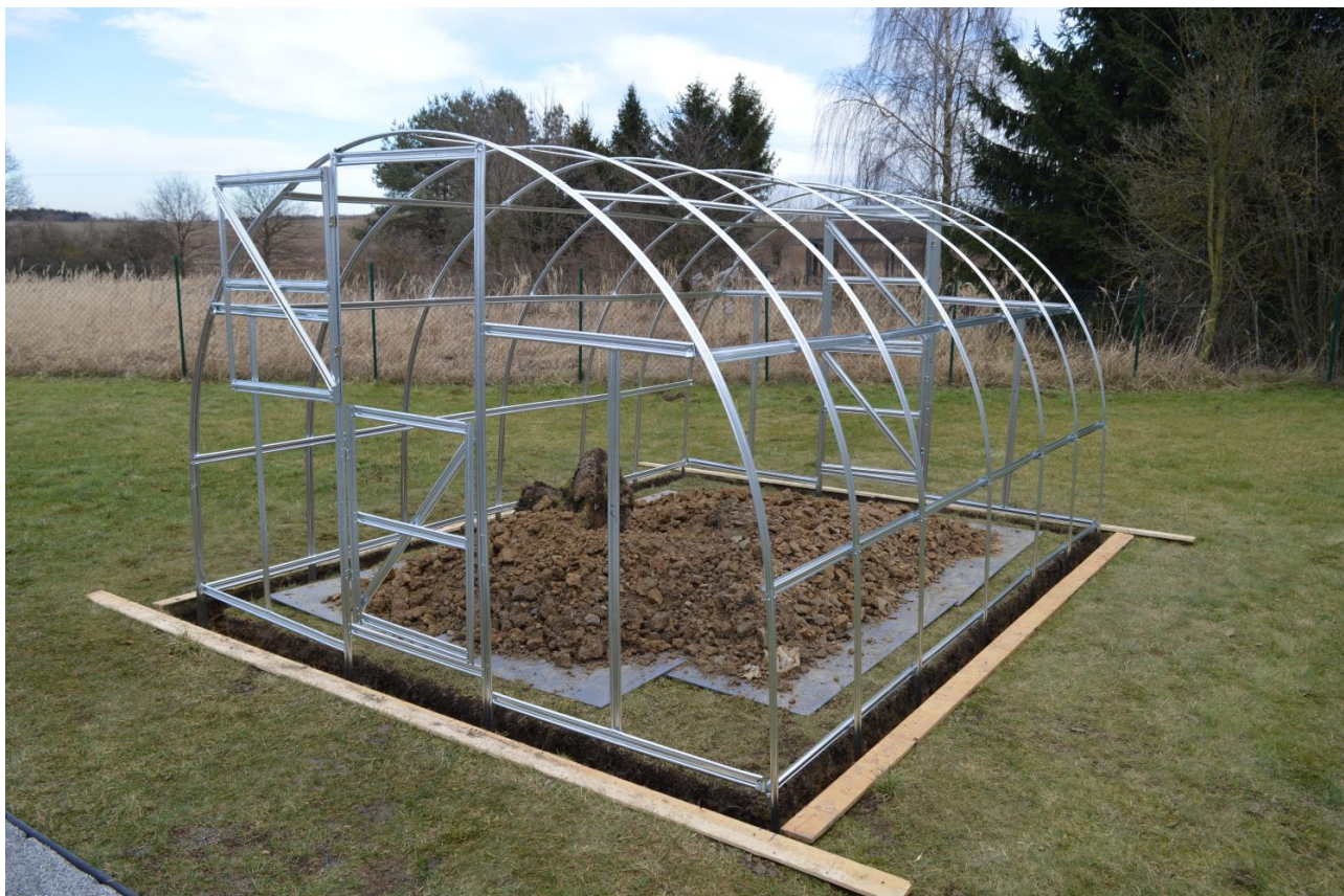
Ilustratívna fotografia spôsobu kotvenia jedného z väčších modelov – úplne zhodný postup (jednotlivé profily sa môžu svojou polohou odlišovať v závislosti na modeli, rozmeru a na roku výroby skleníka)
