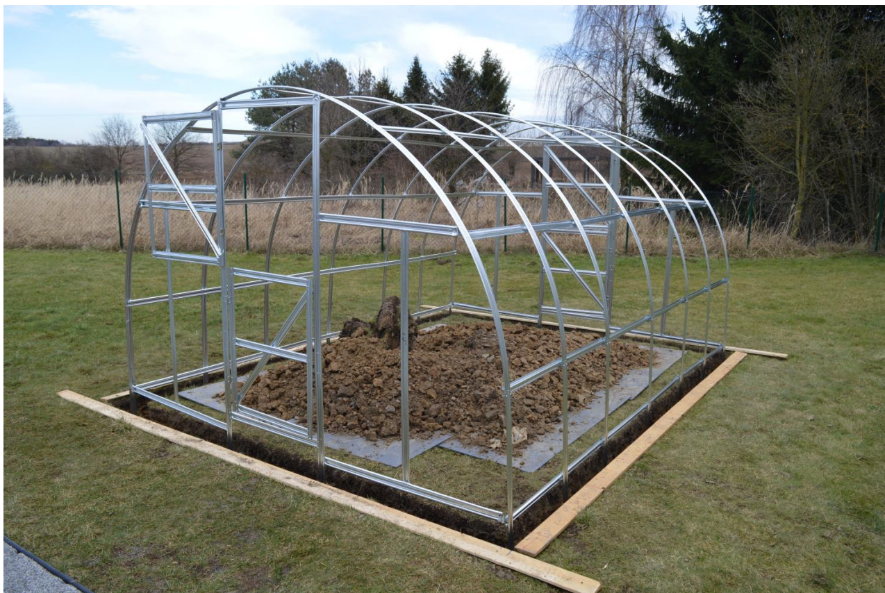
Ilustratívna fotografia spôsobu kotvenia do zeme (jednotlivé profily sa môžu svojou polohou odlišovať v závislosti na modeli, rozmeru a na roku výroby skleníka)
